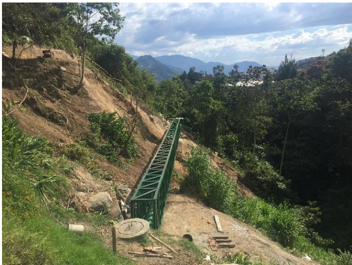
Construcción y montaje de estructuras metálicas
